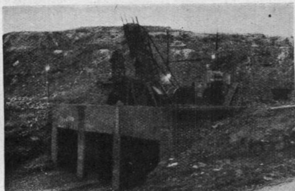
Molienda de pirita y tolvas de carga en el grupo minero «Santa Teresa». Mina «Brunita».
