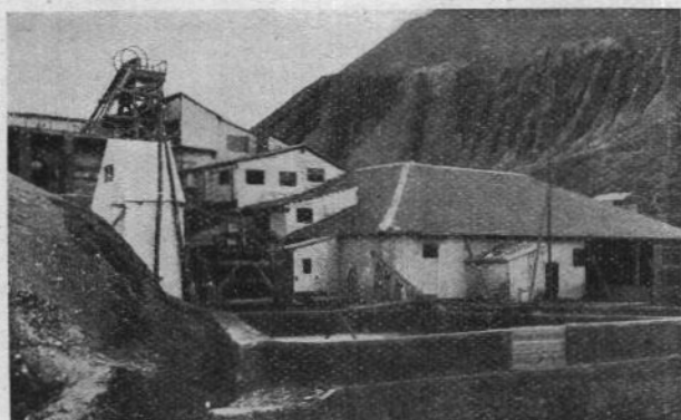
Vista del lavadero de flotación del grupo minero «Segunda Paz», de galena, blenda y pirita.
